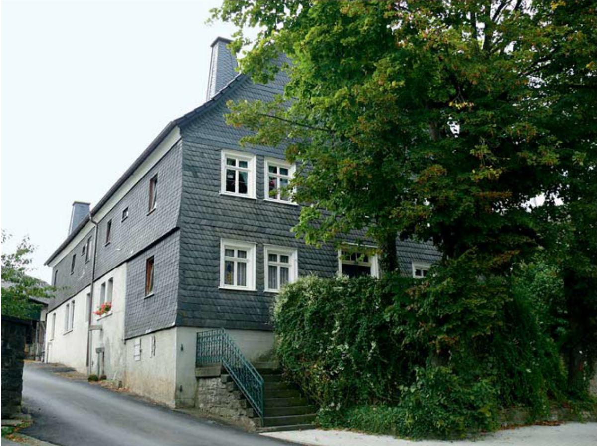
Abb. 6: Ein hoher Preis für die Zufahrt zu einem Discounter in der Ortsmitte: Wird das Bauernhaus Börger mit seinem repräsentativen Eingangsbereich abgerissen, oder findet sich ein Weg, die Geschäftsansiedlung mit den Zielen des Denkmalschutzes zu verbinden? (Foto: Daniela Köhler, 2009)
